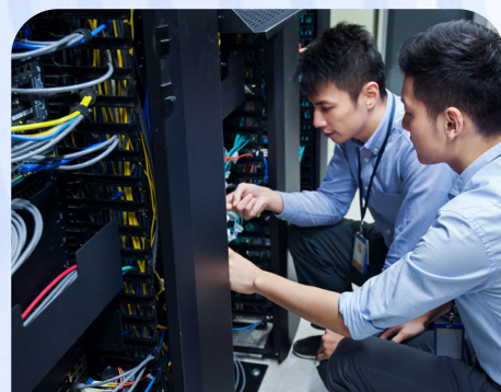
光缆施工维护
