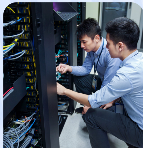
光缆施工维护
