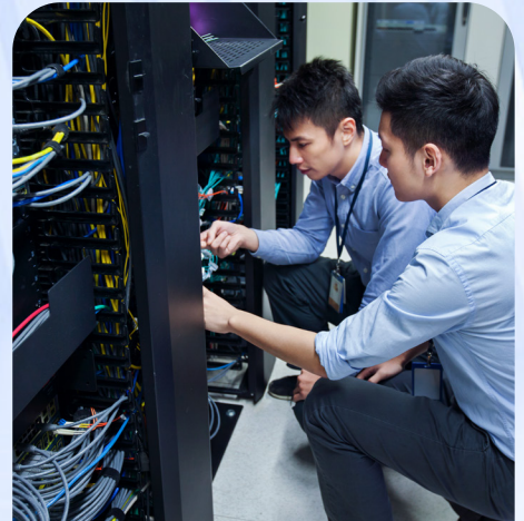
光缆施工维护
